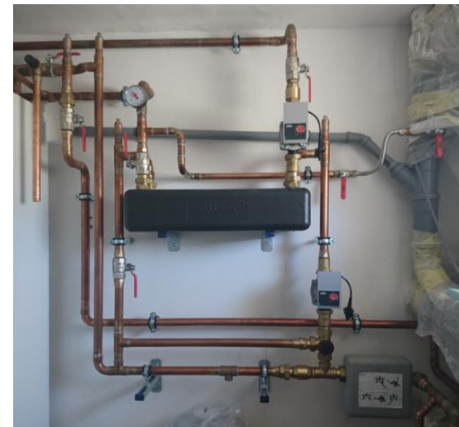
Hydraulika pasivního chlazení v místě instalace
