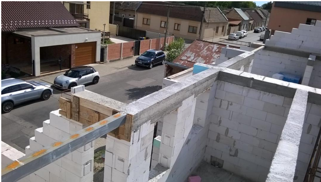
Ocelovy nosnik ako súčasť žb venca (v rovnakej hornej výške)
